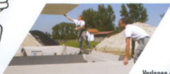
Verlegen der Filigrandecke
